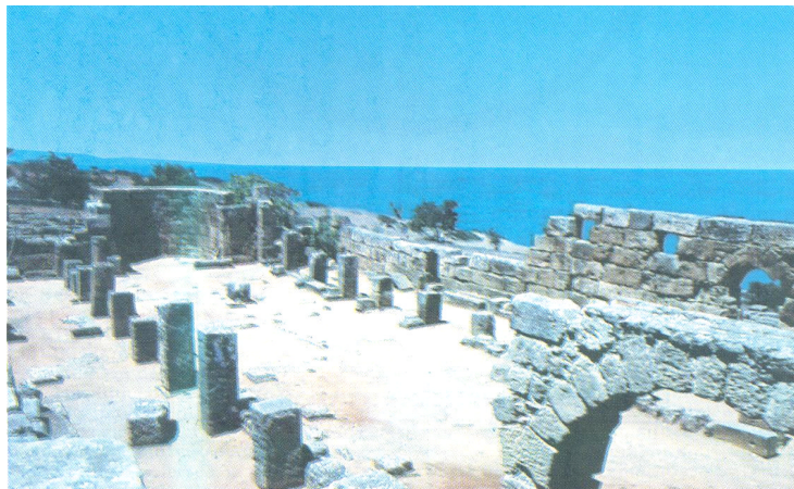
Fig. 8: La basilique de Sainte Salsa. Source : le guide du site de Tipasa 2006
