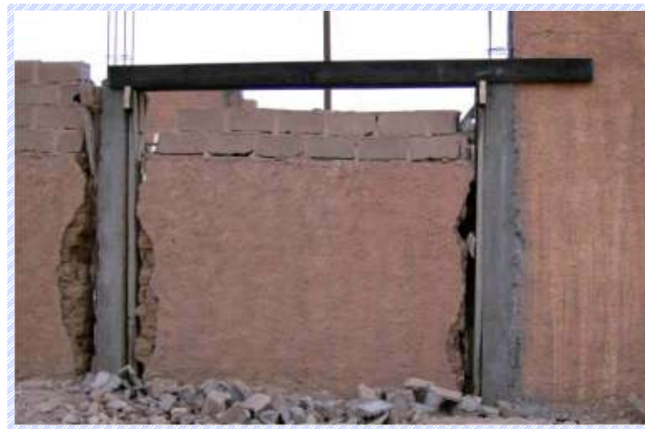
Photo 14 : fragilisation d'un mur en terre, par l'introduction D'une structure en béton armé, avec enduit en ciment
