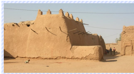
Photo 6: Sultanat de l'Aïr à Agadez, construite en pisé
