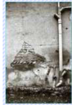
Photo 13 : Quelques cas de dégradations sus citées (décollement d'enduits suite à une accumulation d'humidité, érosion bas de murs et impacts descente d'eau le long des murs)
