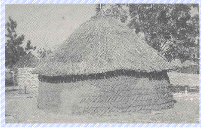
Photo 4 : Case avec maçonnerie en brique d'adobe
