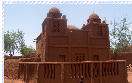
Photo 8 : Maison en Pisé dans la zone de Tahoua
