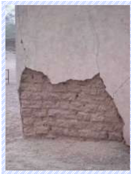
Photo 13 : Quelques cas de dégradations sus citées (décollement d'enduits suite à une accumulation d'humidité, érosion bas de murs et impacts descente d'eau le long des murs)
