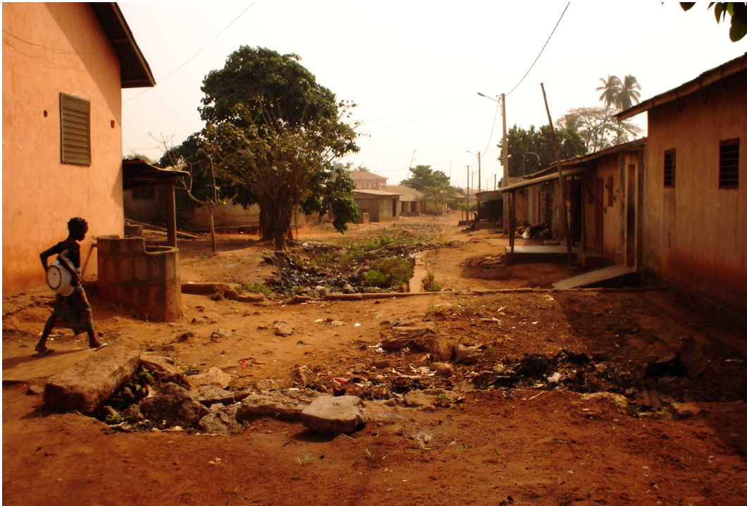
Photo 14 : Impraticabilité de la voie à l'intérieur de l'ancienne ville à Calavi-Kpota
