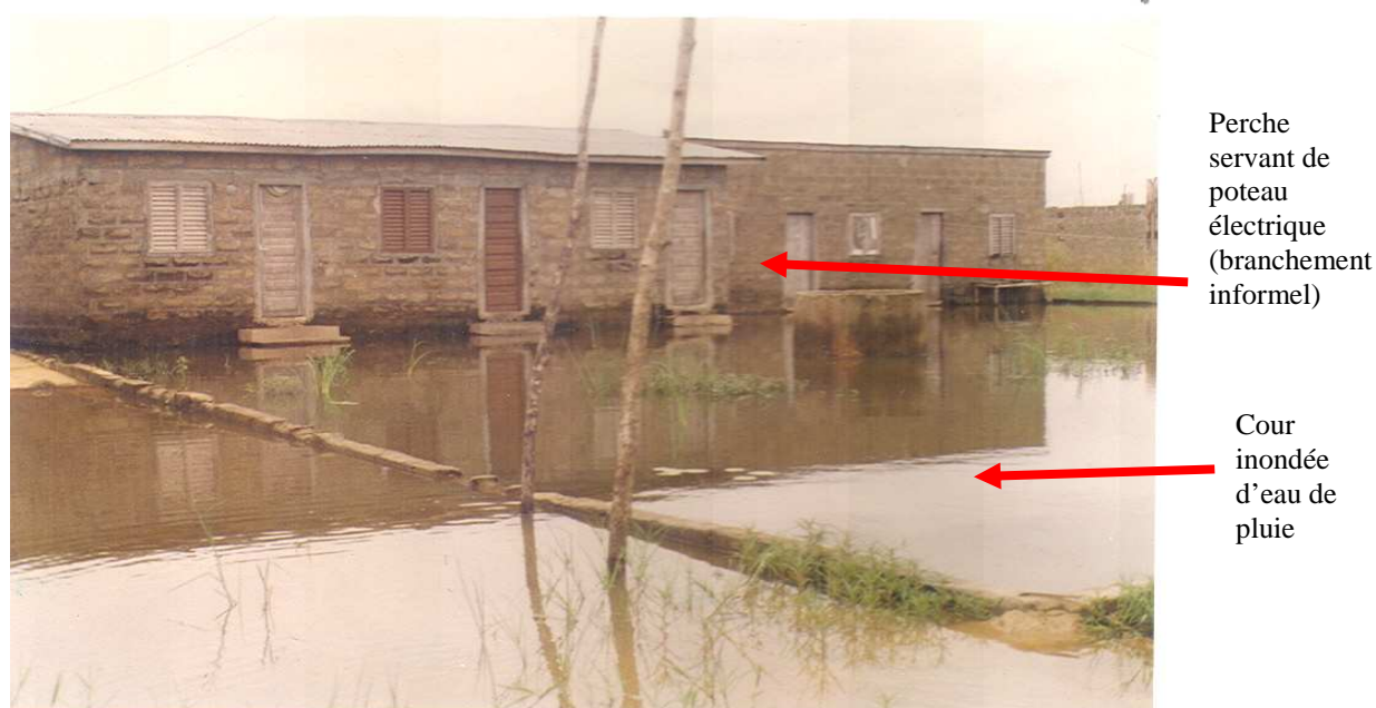
Photo 05 : Habitations inondées et délaissées par les occupants le long de la digue de Godomey-Togoudo
