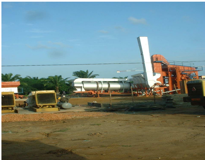
Photo 11 : Base d'entreposage d'équipements lourds de SATOM
