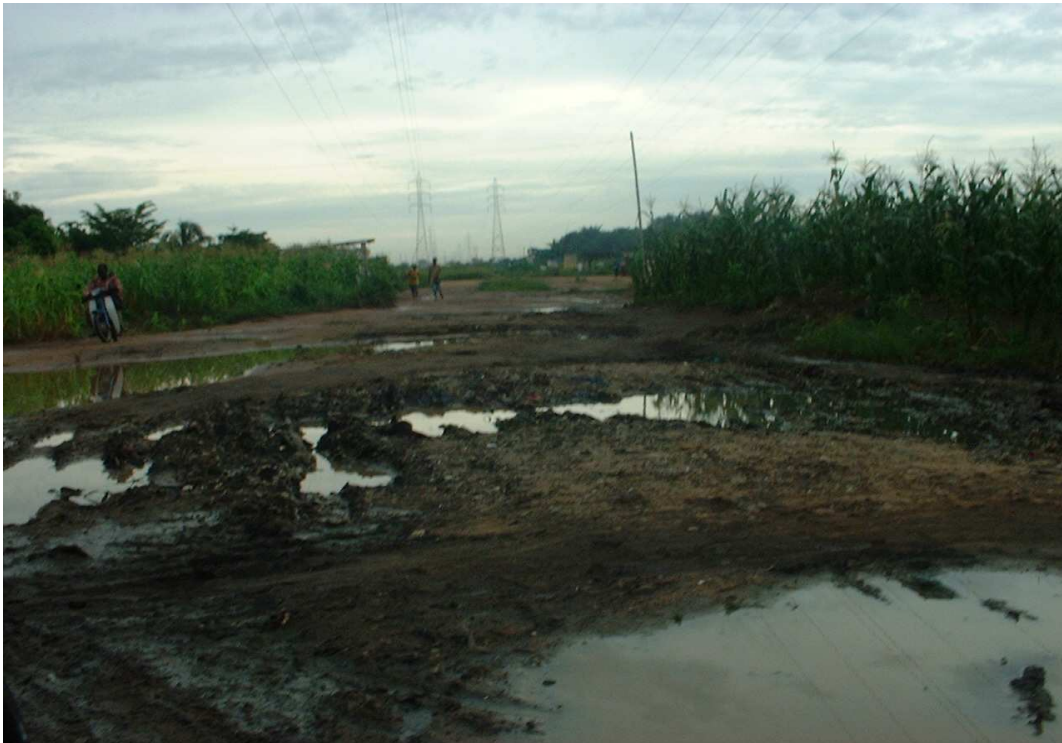
Photo 15 : Etat de la voie à Maria Gléta après les pluies
