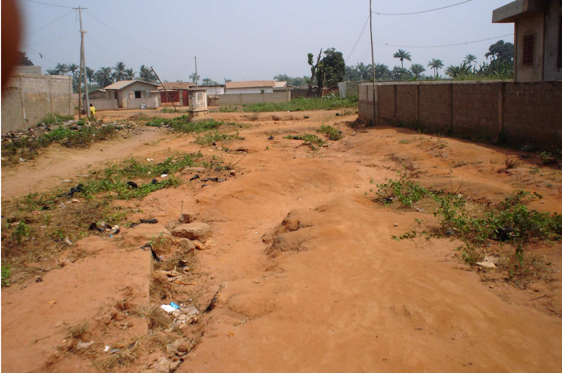
Photo 16 : Effet de l'érosion hydrique dans les rues
