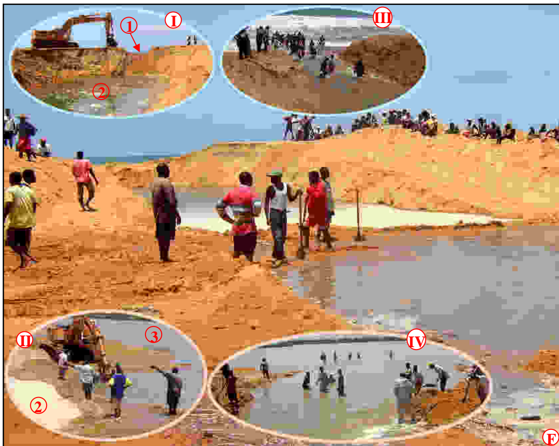
Photo 21.- Photographies montrant les opérations d'ouverture d'embouchure de la BR 3 _09 à Avlo
