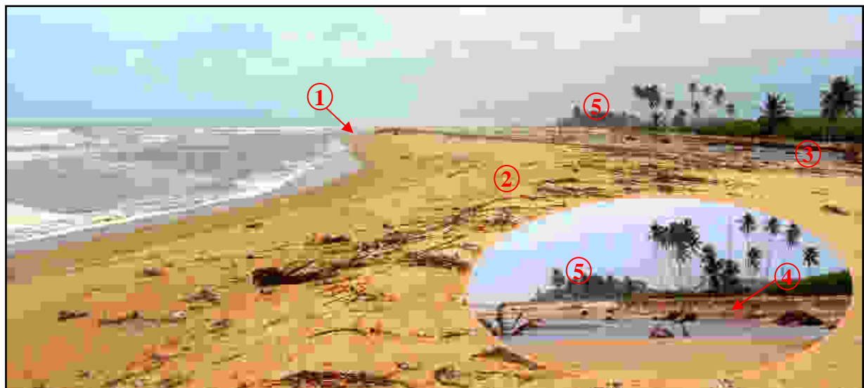
Photo 15.- Photographie (prise regard face à l'Ouest) montrant la position de la Bouche du Roi en face du village de Docloboé en août 2007 et les méfaits de l'érosion Situé le village de Docloboé sur la carte de la figure 56 pour entrevoir le site photographié. Cliché LAIBI Raoul, 26/08/2007
