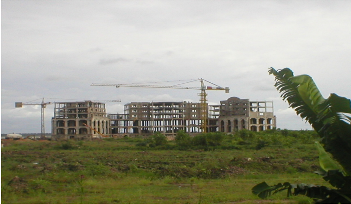
Photo 22 : Hôtel à cinq étoiles en chantier dans la périphérie entre Djassin Daho et Louho (cliché VIGNINO, juin 2009)
