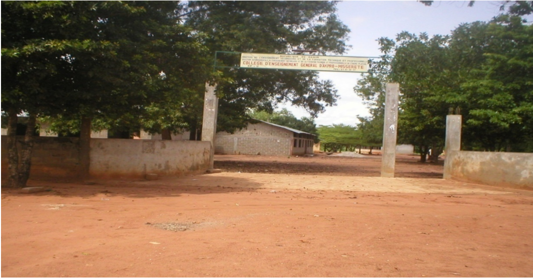
Photo 23 : Le Collège d'Enseignement Général d'Akpro—Misséréte, le quatrième plus grand collège de la périphérie (cliché VIGNINOUE, juin 2009)
