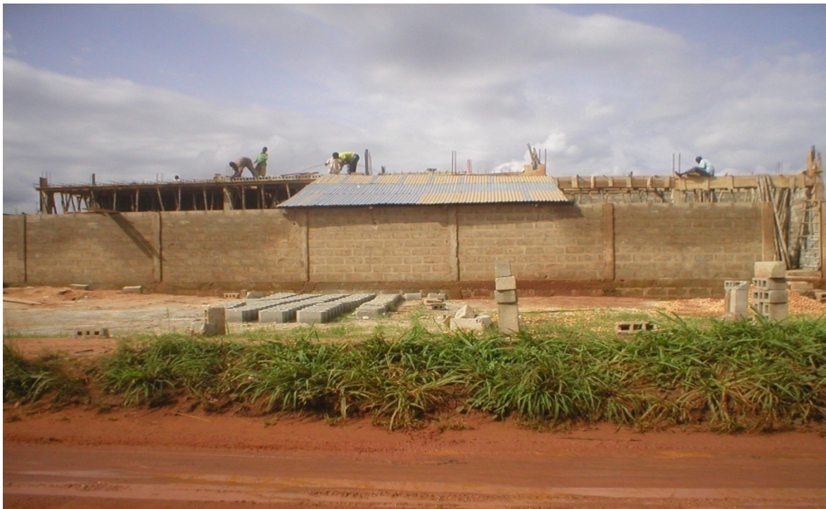
Photo 9 : Maison en chantier dans la périphérie à Louho, (Cliché VIGNINOU, Mai 2009).
