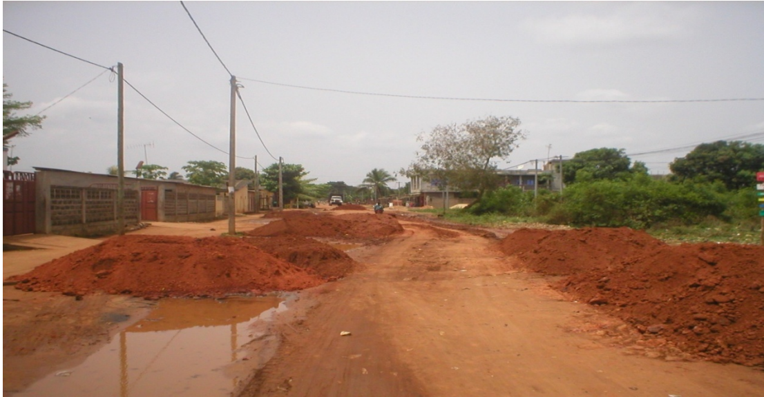
Photo 34 : Rechargement de voie en latérite à Malé (cliché VIGNINO, avril 2009)
