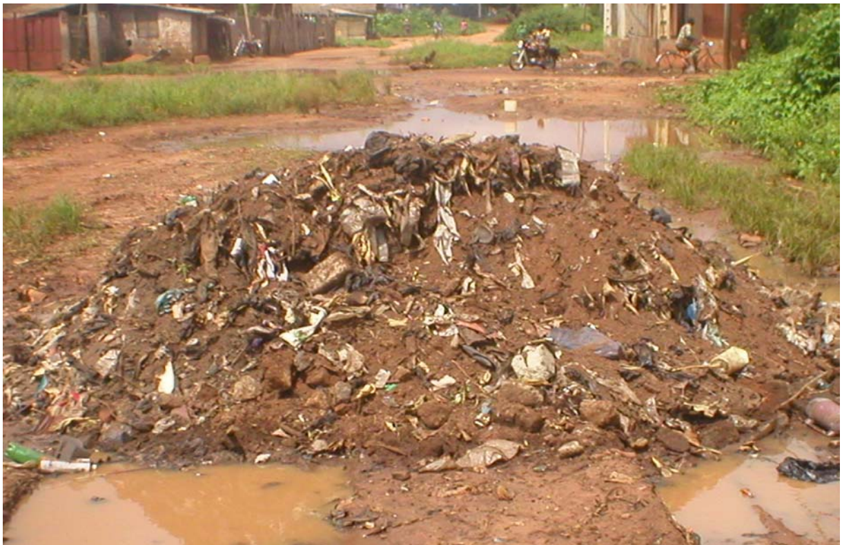
Photo 30 : Rue dépourvue de caniveau, remplie d'eaux pluviales avec un tas d'ordures pour le remblai à Gbodjè (Cliché VIGNINO, juin 2009)
