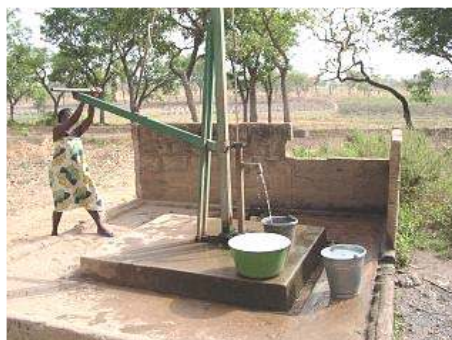
Photo 13 : Exemple de pompe UPM
