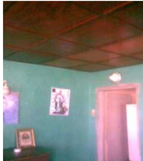
Figure 31 : Habitat avec un plafond sans trou, le mur lisse sans fente et sans espace (Dangbo)
