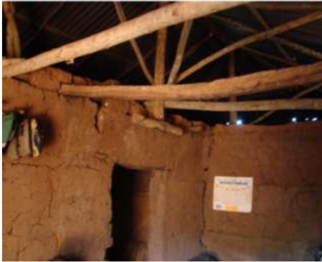
Figure 30 : Habitat présentant beaucoup d'espace entre le mur rugueux et le toit avec de nombreuses fentes dans les murs (Dangbo)
