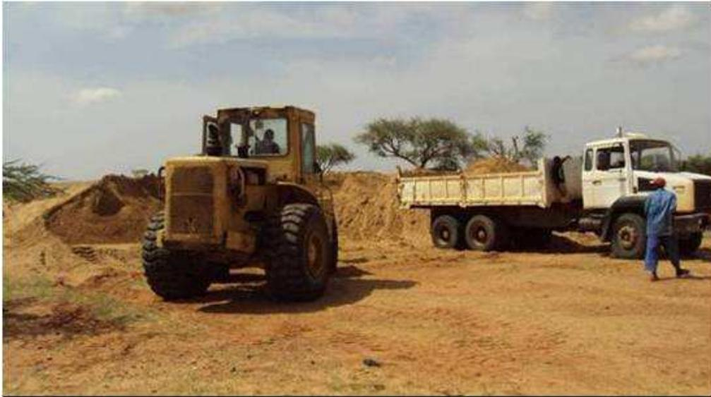
*Photo 114: Sable dragué et transporté et réutilisé pour du béton dans des chantiers environnants*
