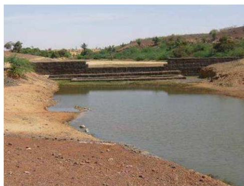
*Photo 102: Dépôt sédimentaire en amont du seuil – barrage du kori Soudouré 2009*
