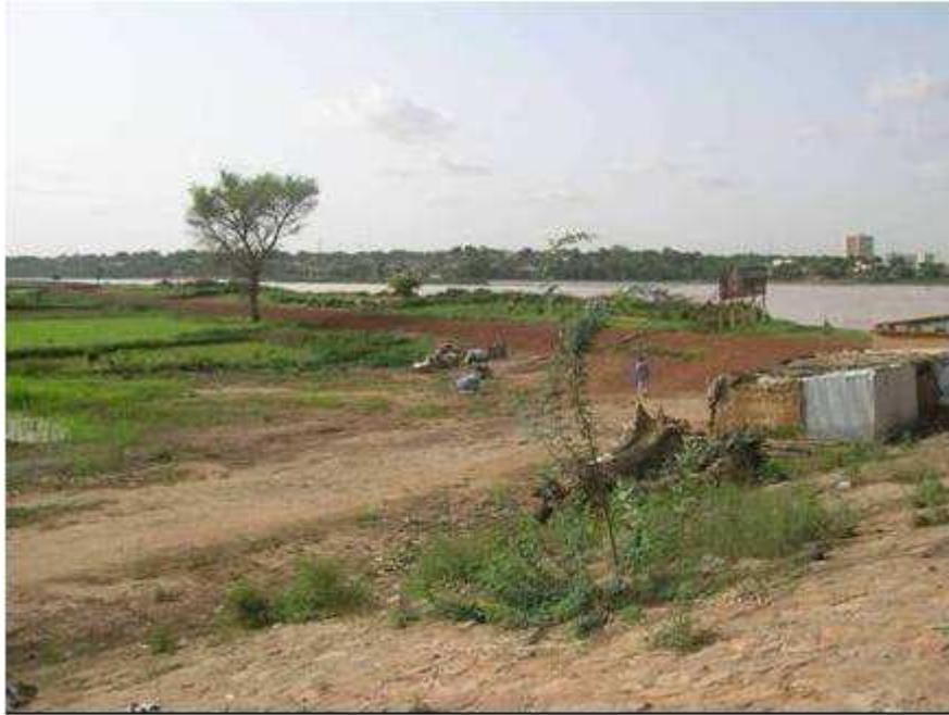
*Photo 126: Digue de protection contre l'inondation construite à Niamey après la crue blanche dévastatrice de 2010 du fleuve Niger*
