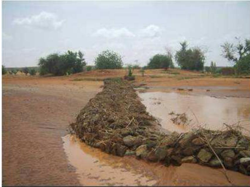
*Photo 119: Seuil d'épandage sur le kori Boubon endommagé juste après sa construction en 2009*
