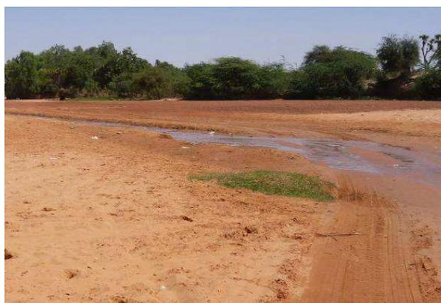
**Photo 47: Piste et parking en latérite réalisé en novembre 2009 sur le cône du kori Kirey**
