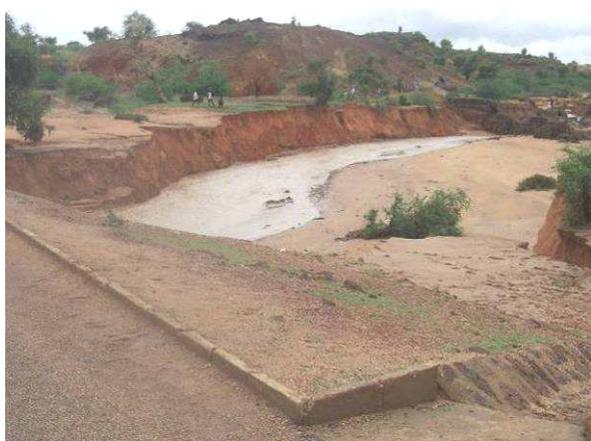
*Photo 105: Section du kori Soudouré en amont du pont emporté à la suite des reculs de berges engendrés par la crue du 5 août 2007*
