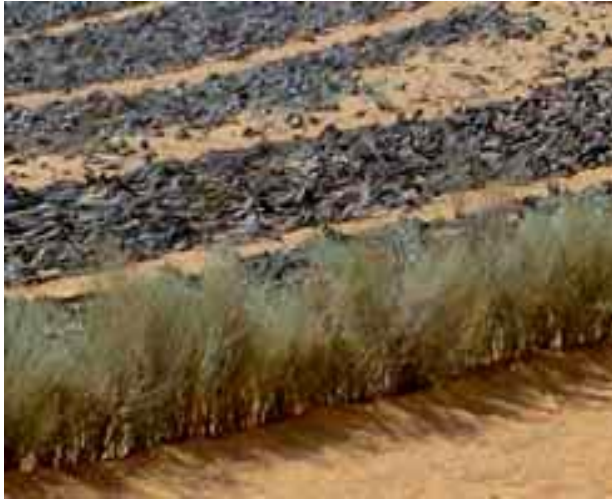
Photo 29 : technique de fixation mécanique des dunes avec épandage des rachis de palmiers doums en rangées
