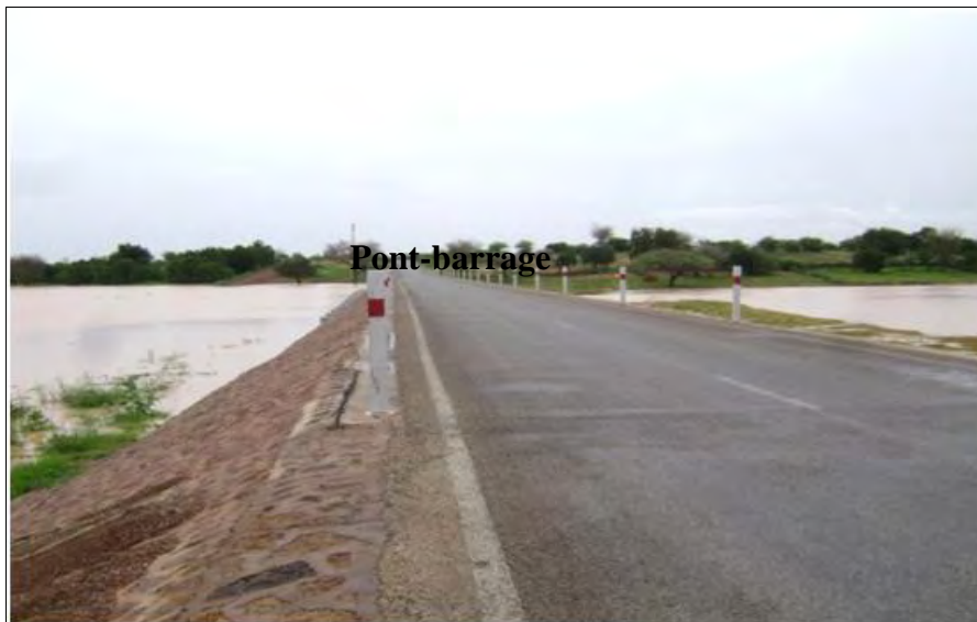
Photo 15: les hautes eaux du kori Mountséka en 2011
