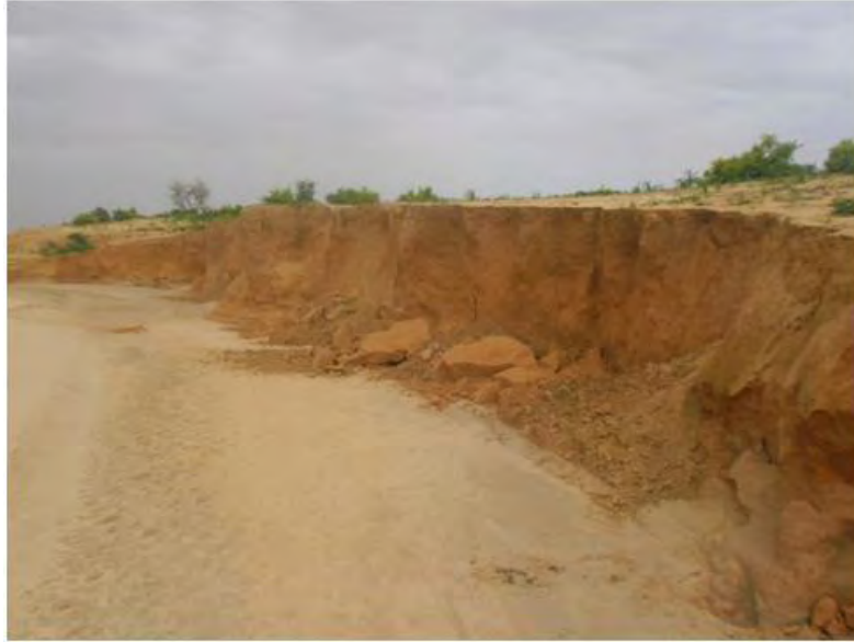
Photo 7: sapement de berge sur le kori Tozo dans la zone aval
