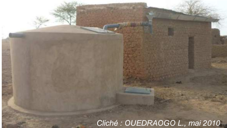
Figure 41 : Impluvium dans le village de Oulo (quartier Tila)
