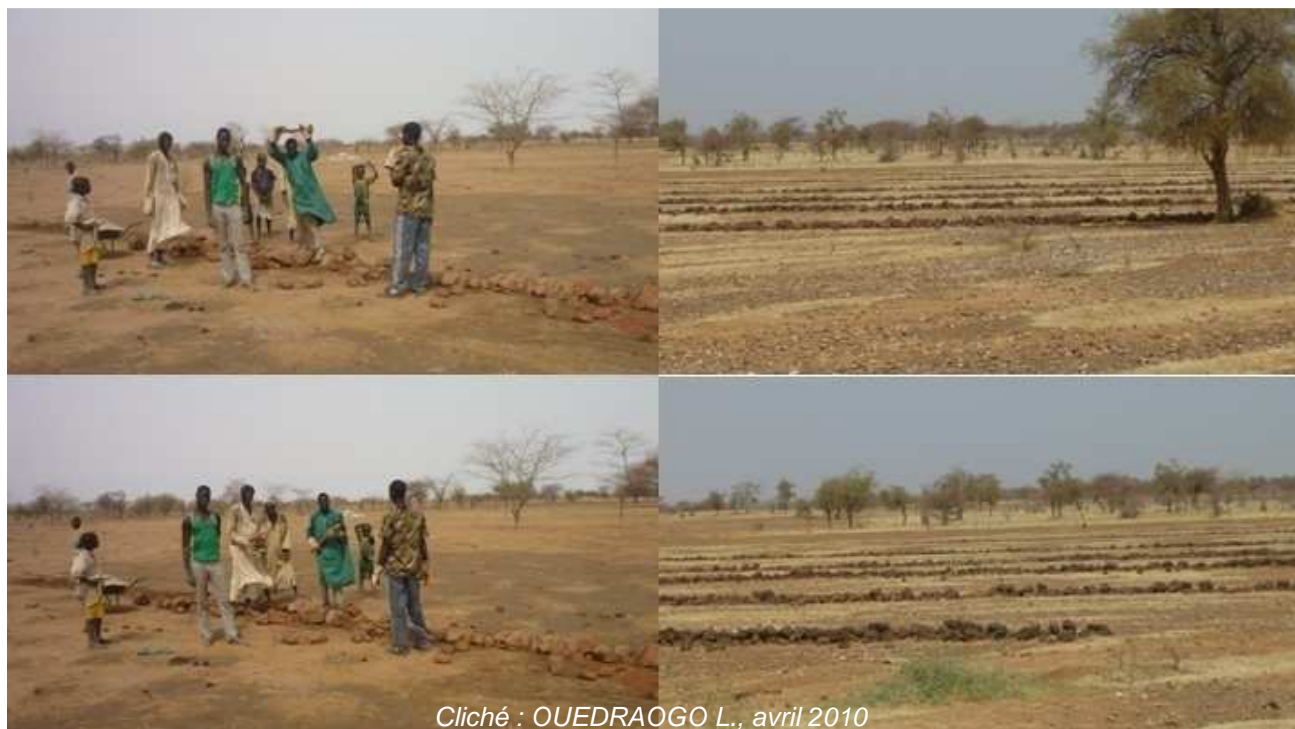
Figure 28: Mise en place de cordons pierreux à Léré
