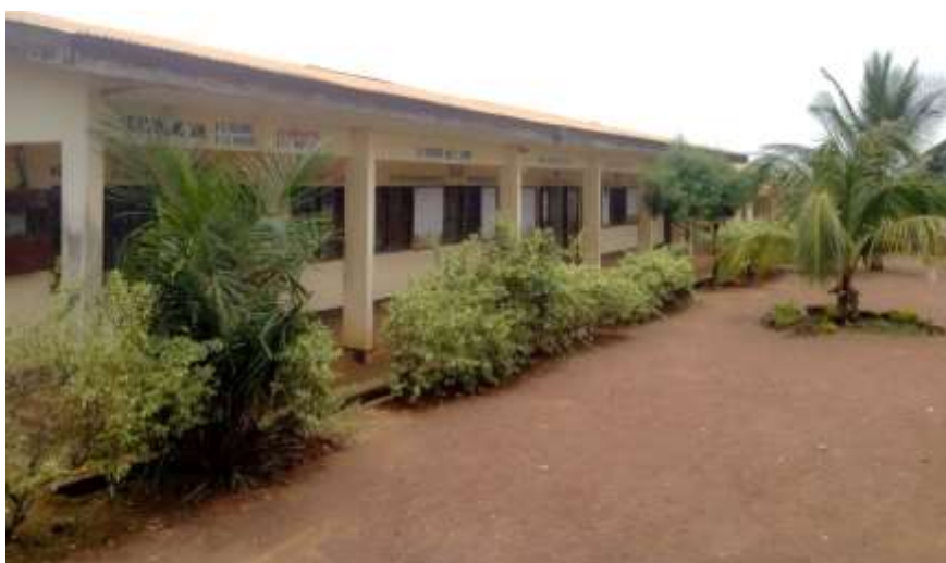
Figure 4 : Bâtiment administratif du Lycée Bilingue de Mfou
