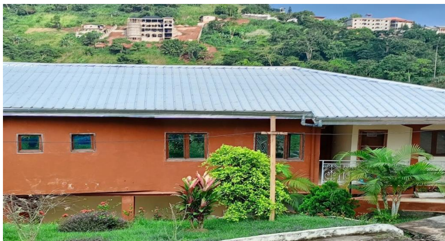
Photo 45: Face principal du nouveau bâtiment du noviciat Saint Kisito de Febe-village, 2023.
