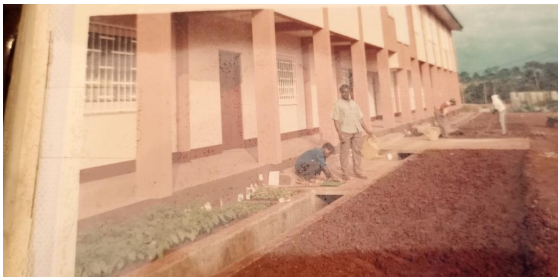
Photo 24: Façade avant de la Résidence des Saints-Apôtres de Nkolbisson en 1990.
