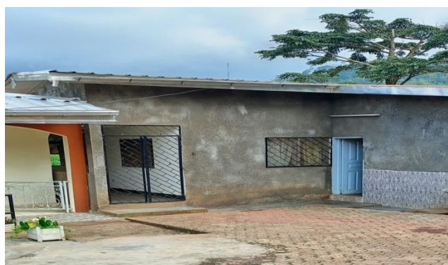
Photo 46: Ancien bâtiment du noviciat Saint Kisito de Febe-village juxtaposé au nouveau bâtiment à gauche, 2023.
