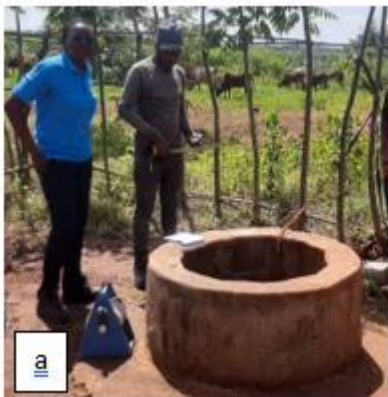
Annexe 2 : : types de margelle (a : mur de parpaing, b : pneus de camion, c : futs)
