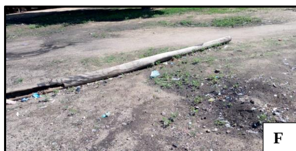
Photo( F) : la vetuste du poteau électrique à Zamay
