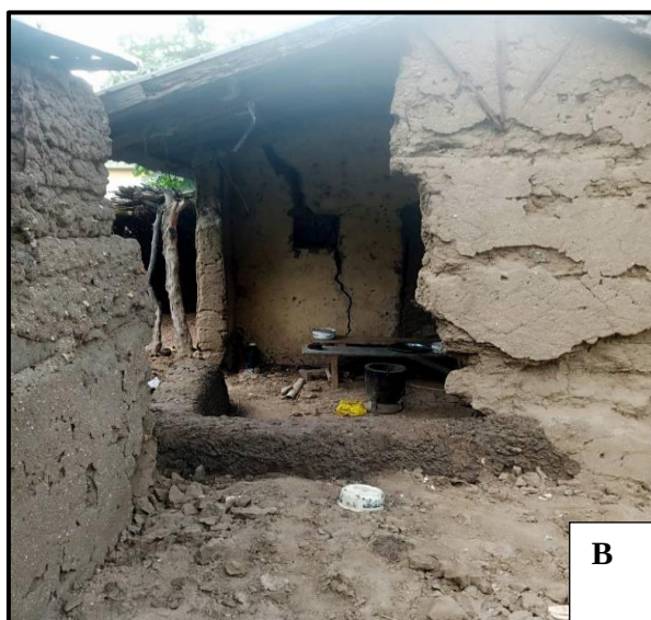
Photo B : Maison en réhabilitation à Zamay
