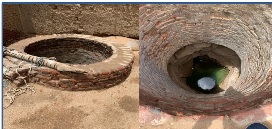
Figure 28 : Eau du puits en contact avec la roche
