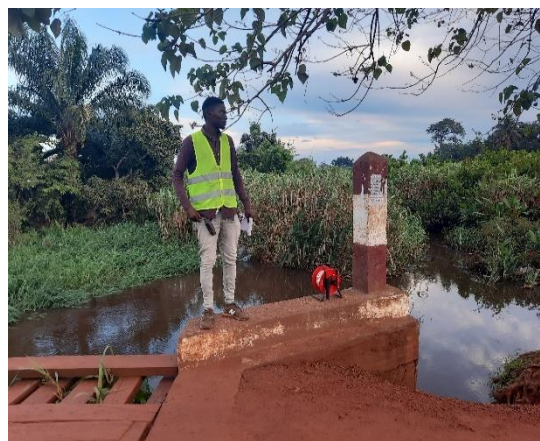
Pont sur le cours d'eau Badombé
