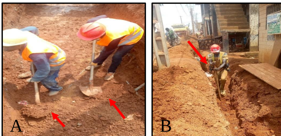
Figure 17: Quelques non-conformités des EPI observées sur le chantier. A , ouvriers travaillant sans chaussures adéquates ; B , ouvrier travaillant sans gants.
