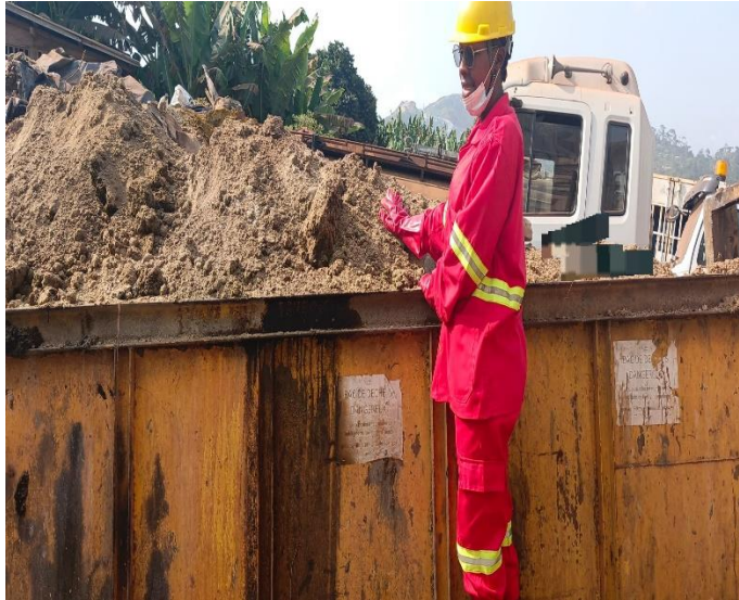
Fig. 9. Bacs distincts prévus pour les déchets dangereux
