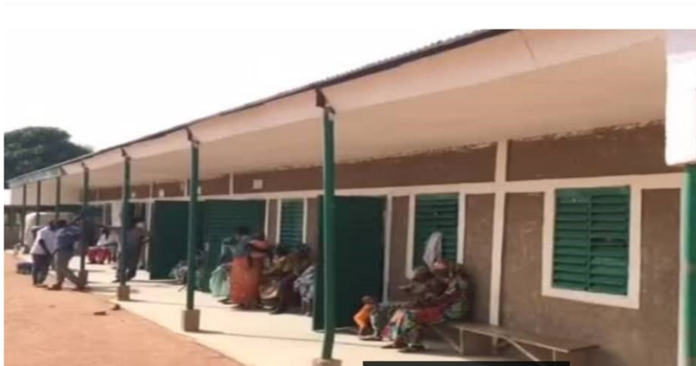
Photo 3: Centre de santé des réfugiés centrafricains, construit à Beureuh au sud du Tchad.
