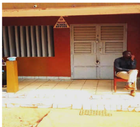
Photo 7 : Premier site du lycée de Ngoa-Ekelle (bloc administratif)
