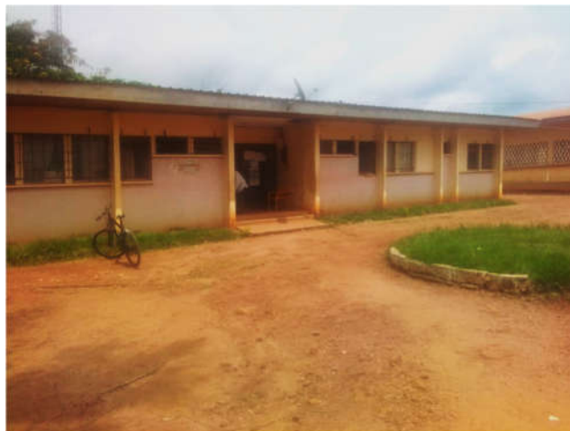
Photo 2 : Enceinte du LYCLANE (bloc administratif)
