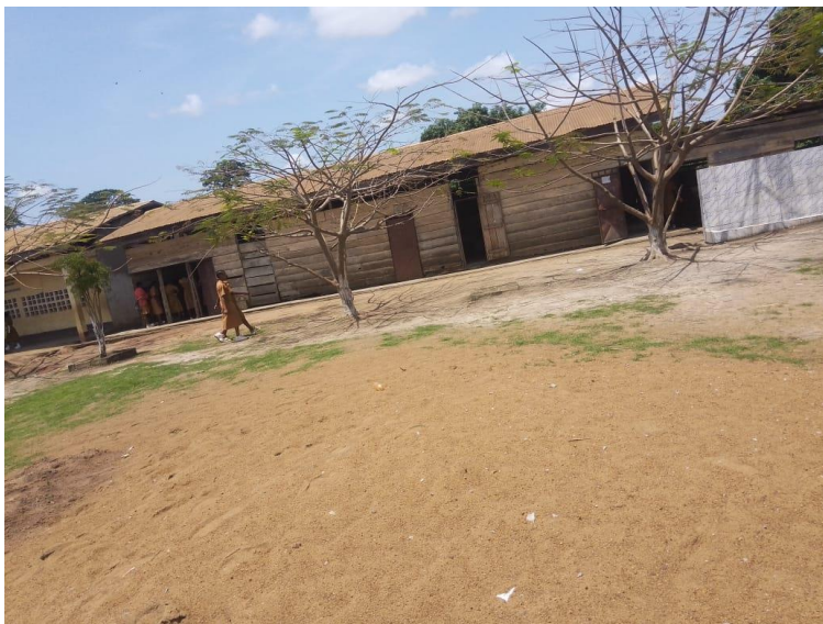
Figure 16: Salle de classe lycée de NKOTENG
