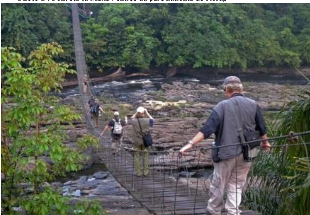
Photo 1 : Pont sur la Mana : entrée du parc national de Korup
