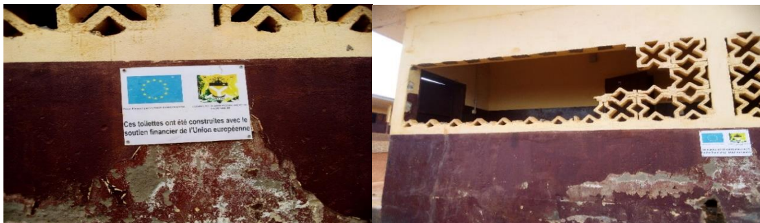
Image 2: Un exemple de partenariat CAY III / UE : toilettes construites à l'école primaire publique les sources de Biyem-assi II. Source : photo prise pendant nos recherches de terrain
