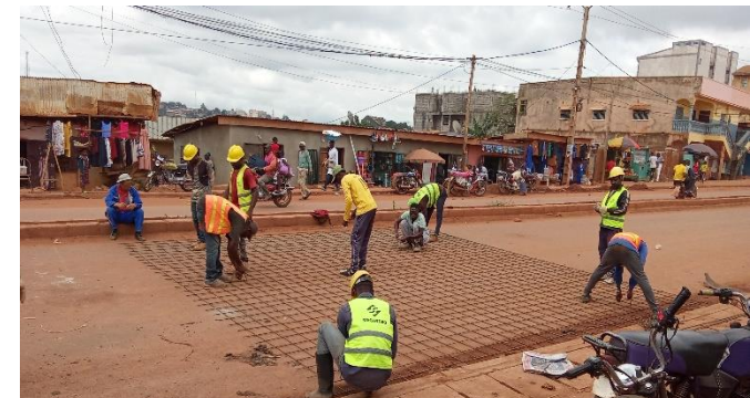
Les manœuvres tissant les fers sans les gangs de protection
