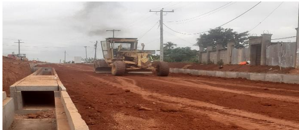
Pollution atmosphérique par une niveleuse
