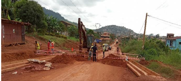
Zone des travaux balisés à l'aide d'une balise de sécurité
