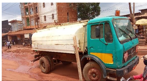
Arrosage des voies de circulation
