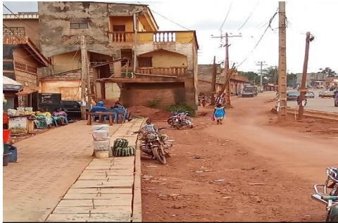
Maison situer sur l'emprise des travaux car n'ayant pas encore reçue l'indemnisation
