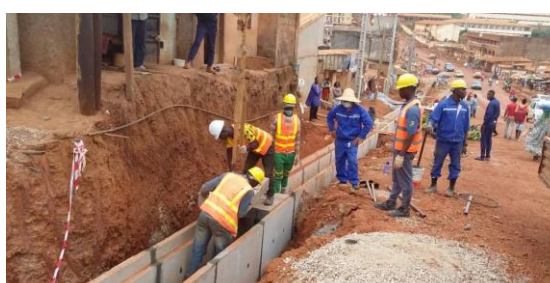
Les manœuvres dotées d'EPI au chantier
