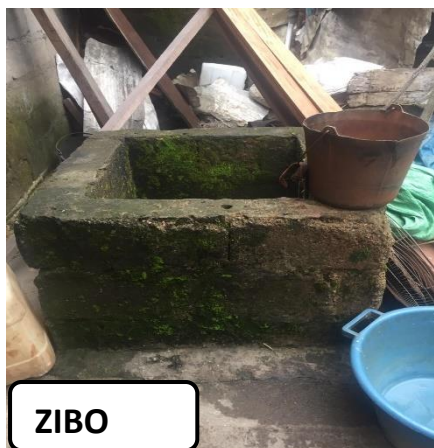
Figure 15 : Images des puits d'eau de la zone industrielle de Bonabéri (ZIBO)
