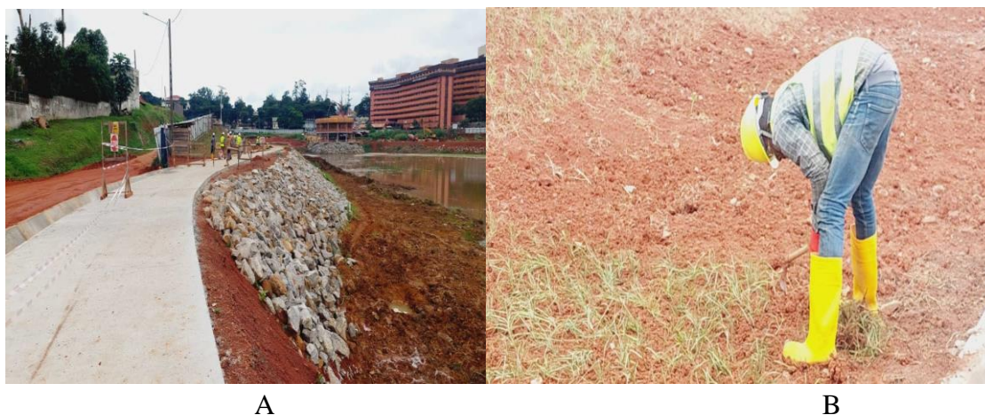
Figure 10: Facies de quelques zones dégradées remises en état
