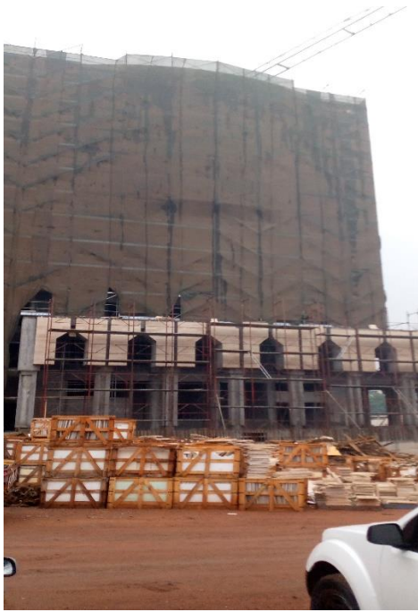
Figure 1. Vue latérale de l'ouvrage
