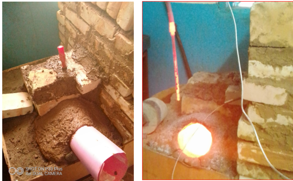
a) moulage de l'orifice du bruleur,
