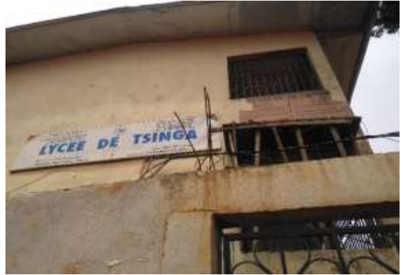
Vue externe du lycée de Tsinga
