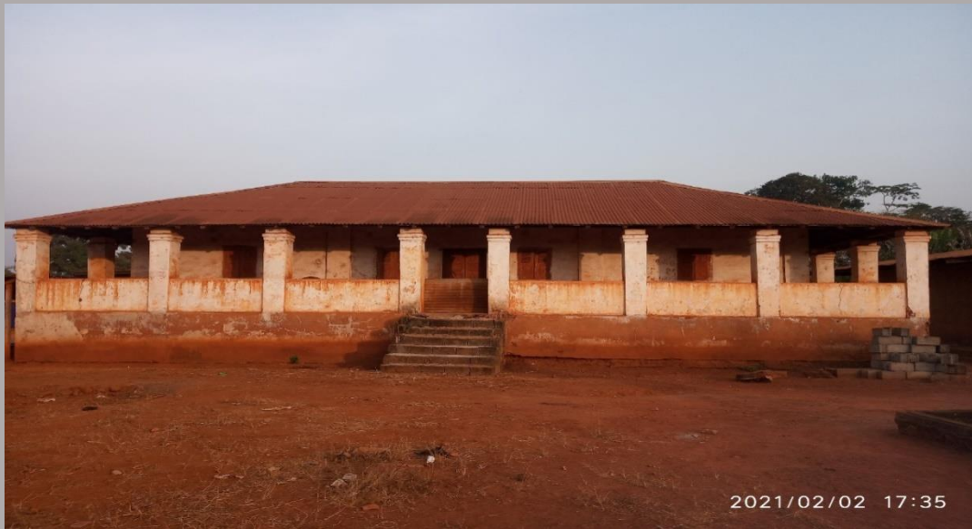
Photo 4 : Palais traditionnel de NGOA EVINA à ESSE
