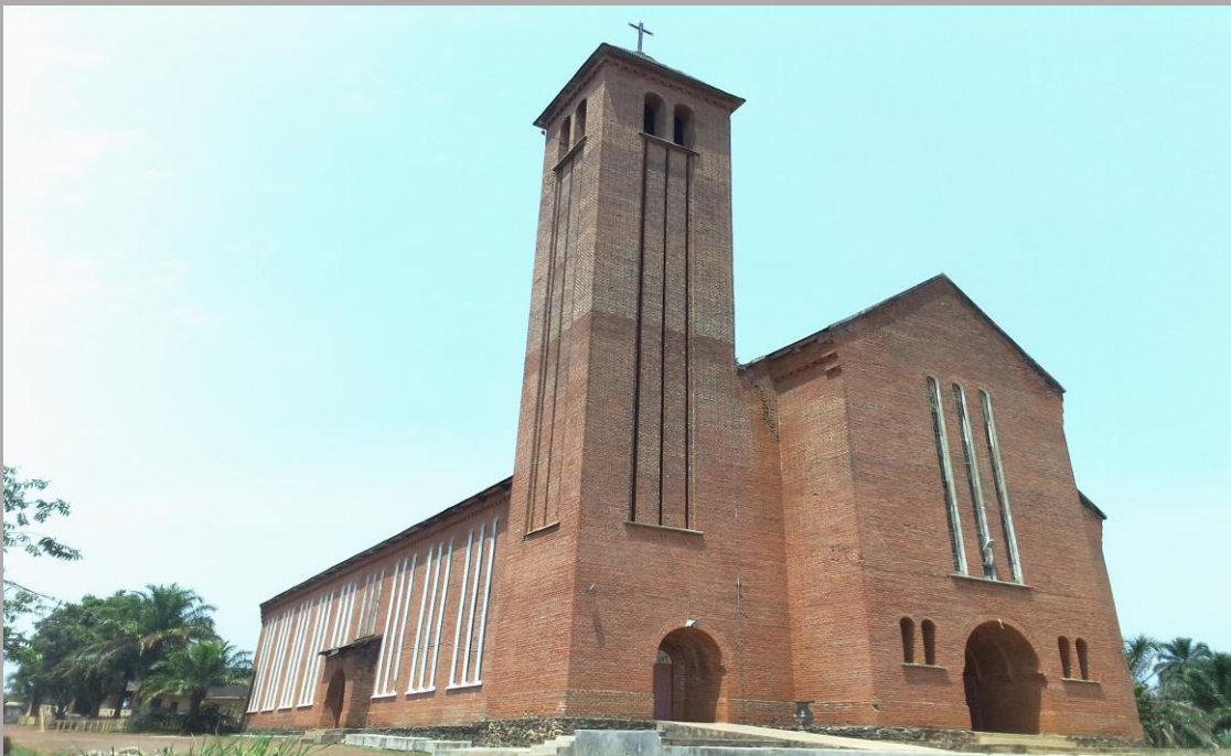
Photo 8 : Eglise Saint-Pierre et Paul de Nsimalen
