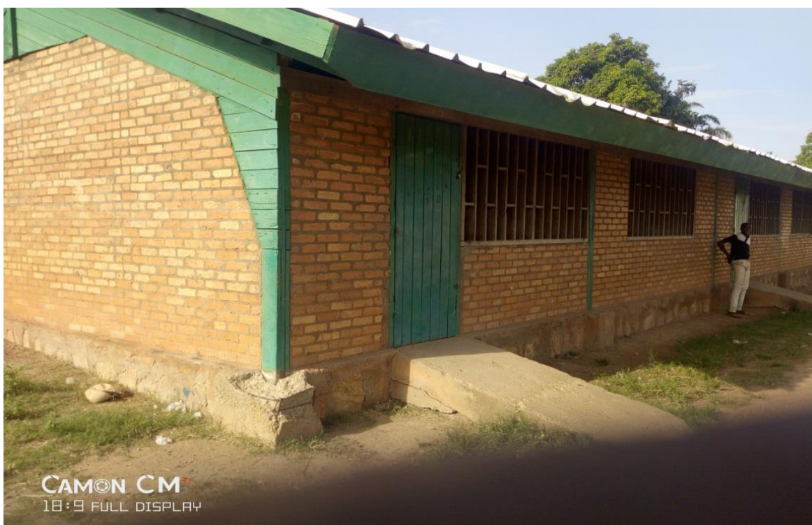
Photo 5 : Un bâtiment de l'école Koudoukou
