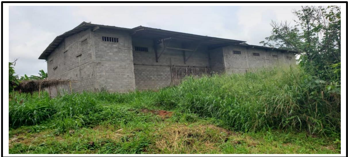
Photo 1 : Bâtiment de l'ancienne entreprise Willy Services
