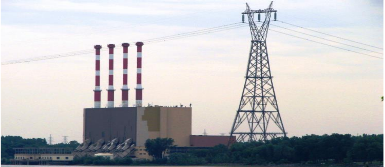
Figure 5: Centrale Thermique à Mazout. (Source : ligne, 2002)
