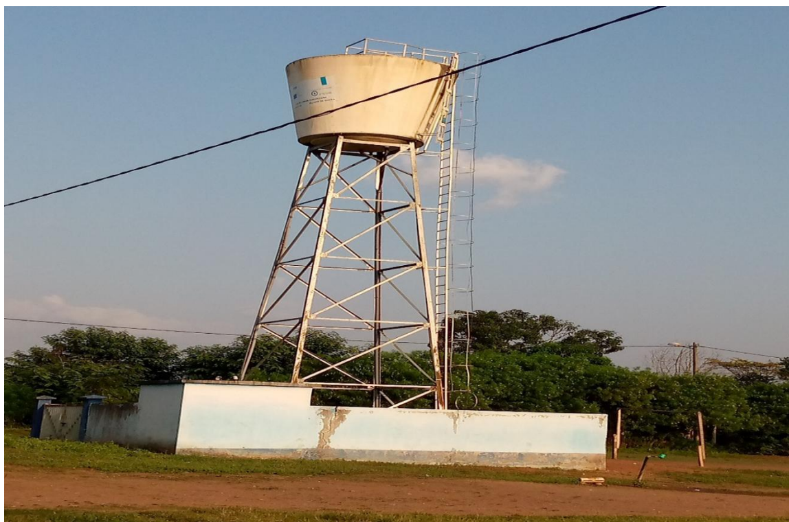
Figure 31 : Château d'eau desservant le quartier autochtone
