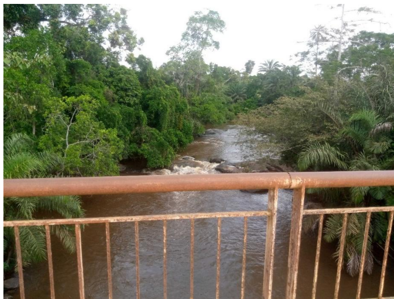
Photo 4: une prise de vue de la rivière Gia à partir du pont de Doba
