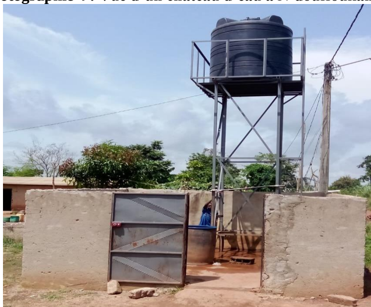
Photographie 4 : Vue d'un château d'eau à N'douffoukankro
