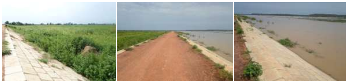
Photo 18 : Portion de la digue en pavé, fruit de la coopération chinoise à Malanville
