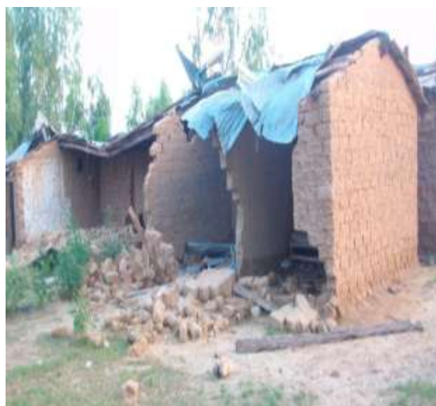
Photo 11 : Une maison en banco écroulée sous l'effet des eaux à Malanville
