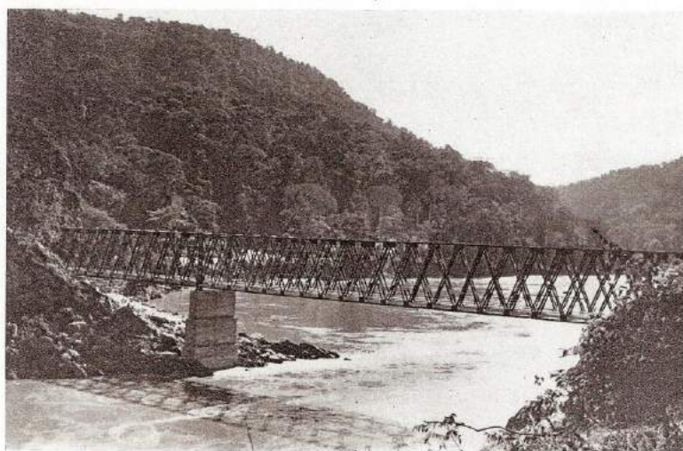
Photo n°26: Le pont provisoire construit au site de Sounda.
