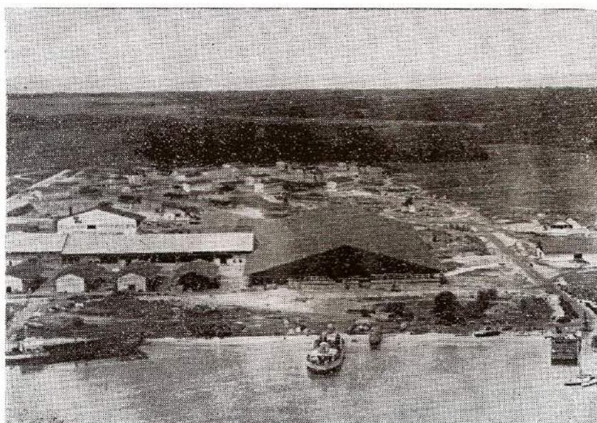
Photo n°22: L'usine de contreplaqués de la CFG.
