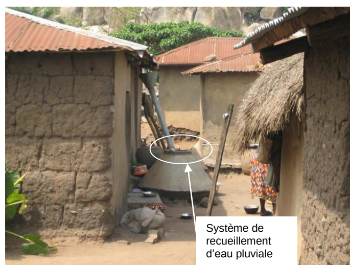
Photo 10 : Type de jarre d'entreposage de l'eau de pluie dans le secteur d'étude
