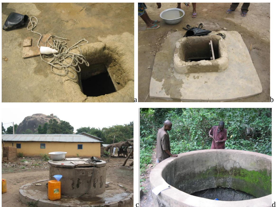
Photo 7 : Puits non protégés dans le secteur d'étude
