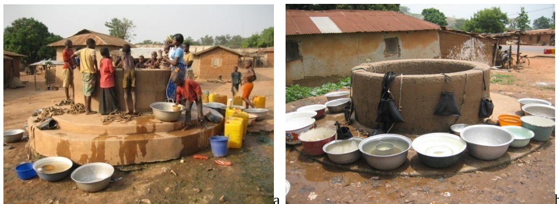
Photo 21 : Système de puisage au niveau des puits de Bobè Djagbalo (a) et de Bantè Gbégamey (b)
