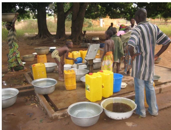
Photo 8 : Forage (pompe à motricité humaine) à Pira-Adjadji
