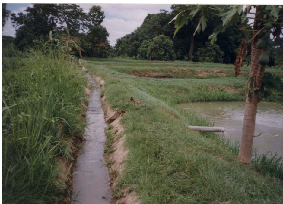
Un canal d'alimentation à Korhogo (Nord)
