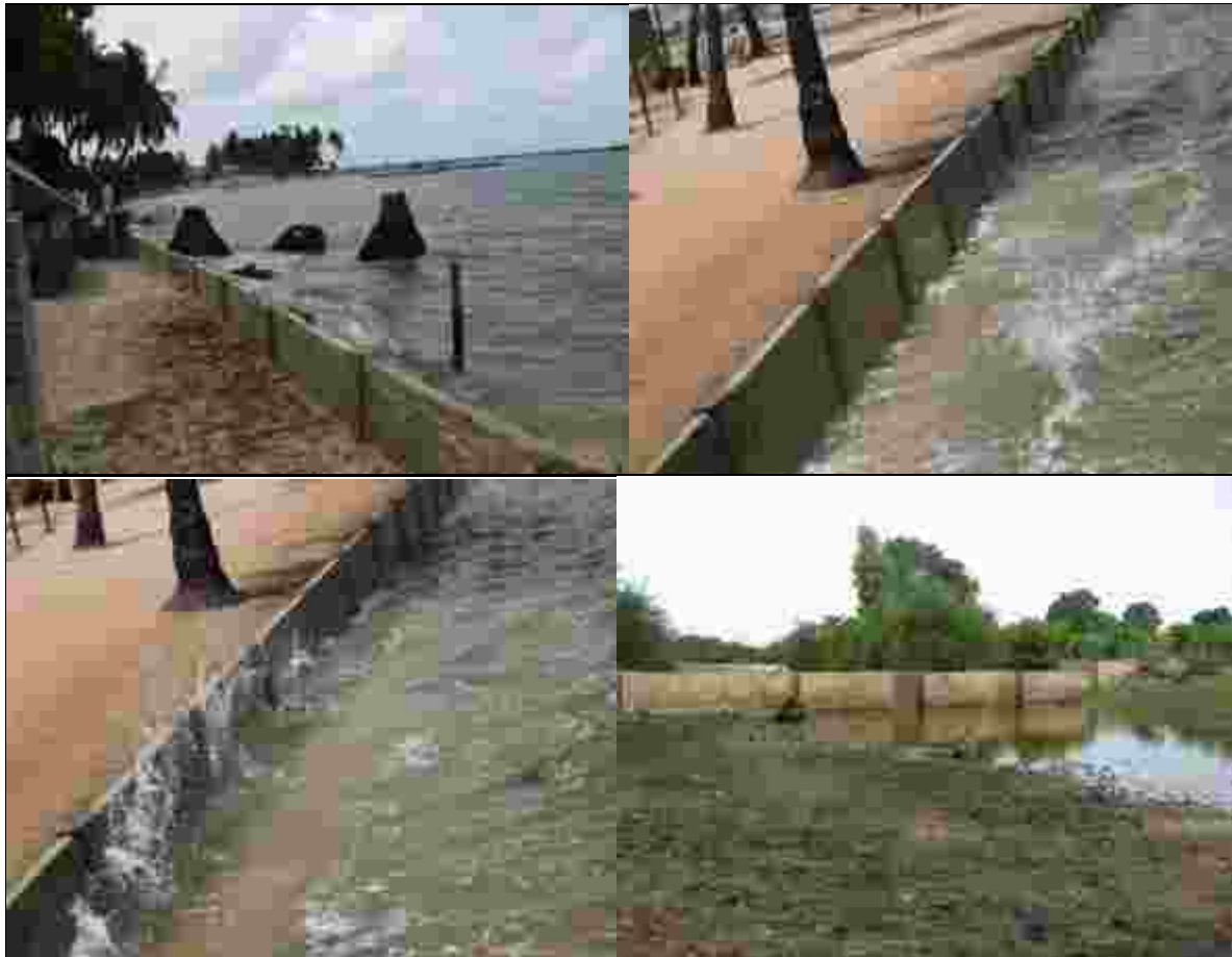
Photo 38: mur de protection du village de Dionewar
