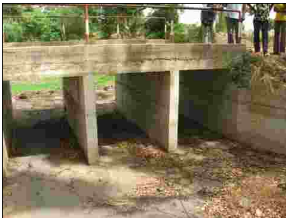
Photo 34: Vallée de Senghor, pont barrage de Ndiop Ndienguene
