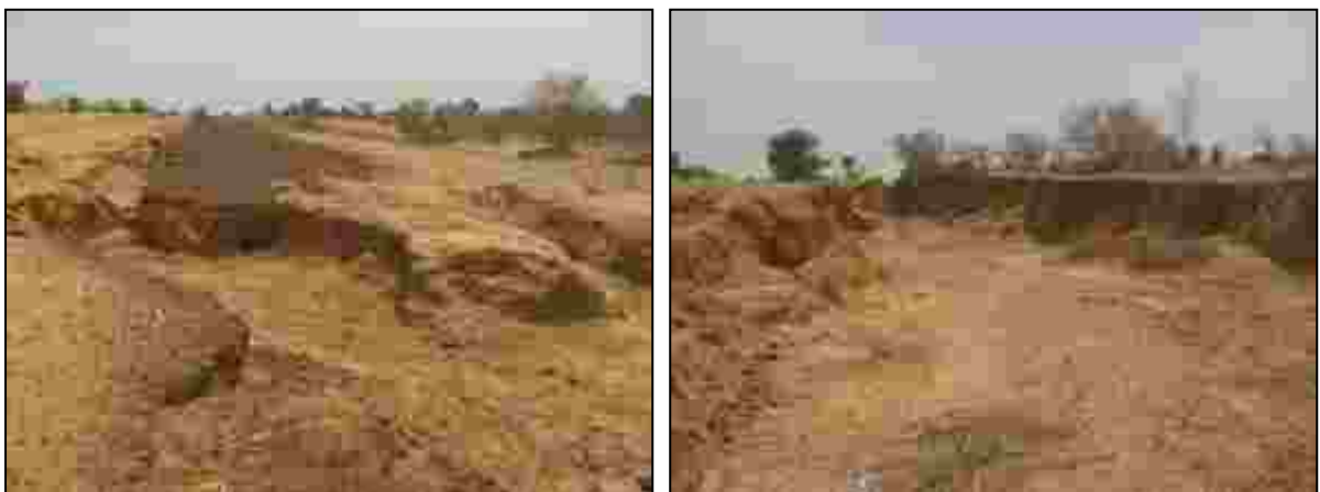
Photo 23: impacts de l'érosion hydrique à Djanké Souf (Malem Hodar)
