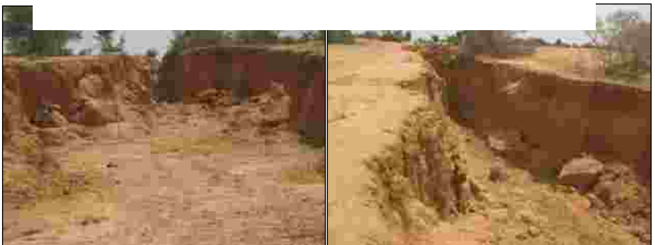
Photo 24: impacts de l'érosion à Ndioum Nguenth (Malem Hodar)
