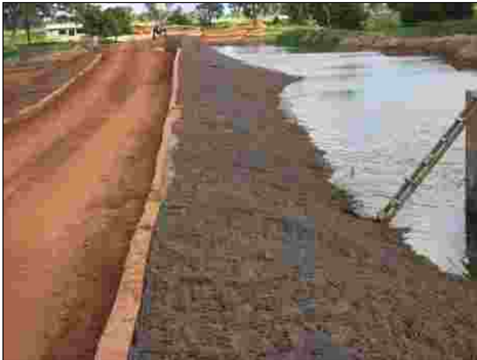
Photo 35: Vallée de Médina Djikoye digue piste entre les villages
