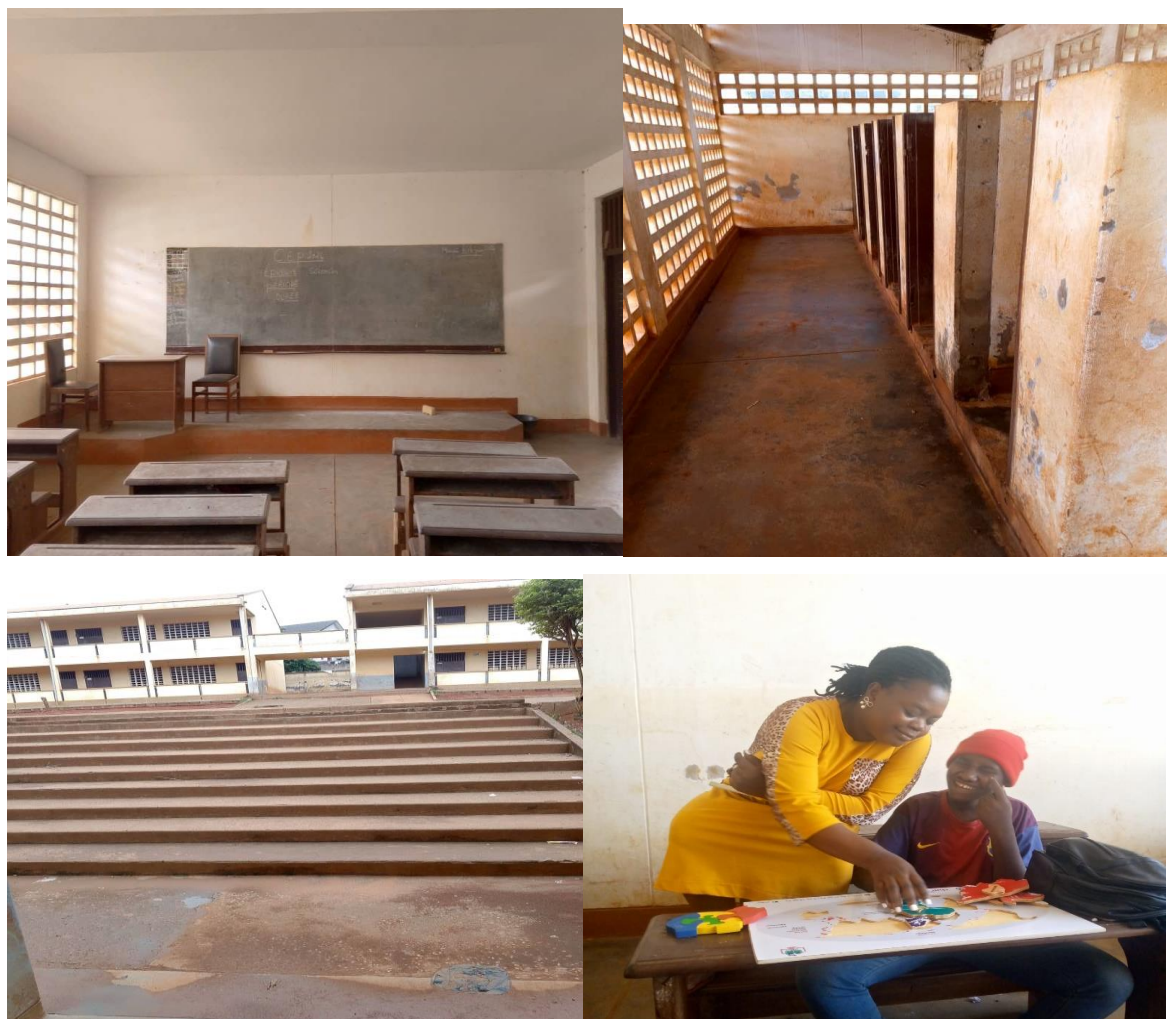
Image 4: Défaillances des dispositifs d'accessibilité de l'école publique de Ngousso
