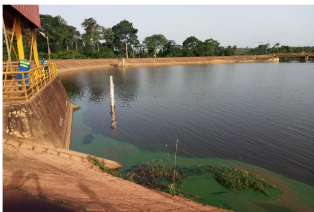
a : Partie Sud du barrage
