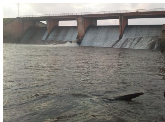
b : Déversoir du barrage
