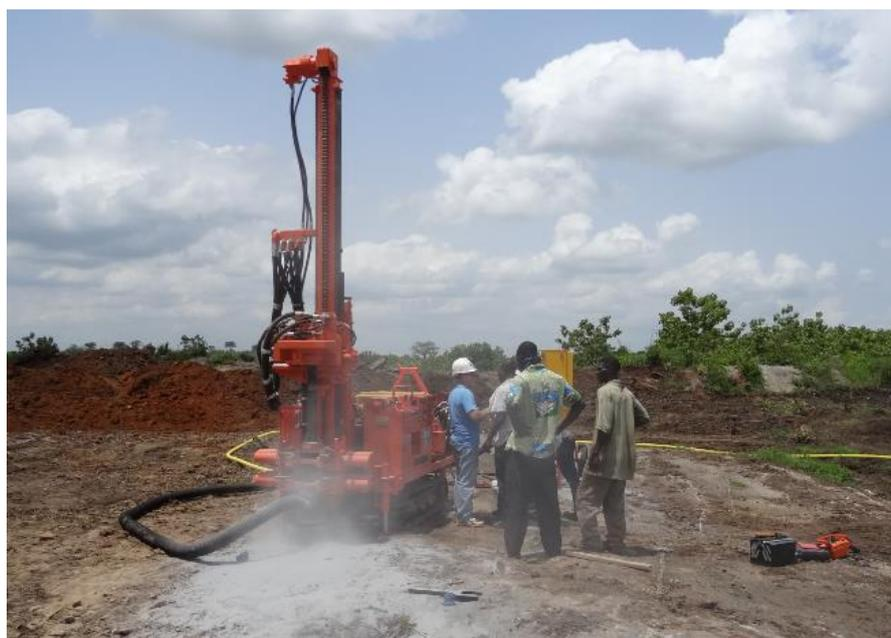
**Photo 3** : Forage de la roche par une foreuse. (Source : Stenuick international, juin 2022)
