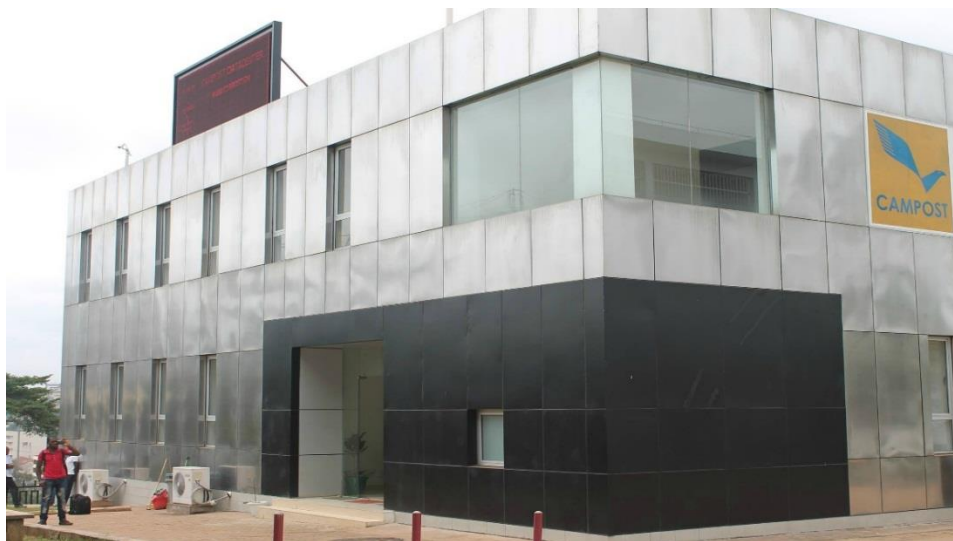
Image 3 : Centre de traitement des données de la CAMPOST (Data center)
