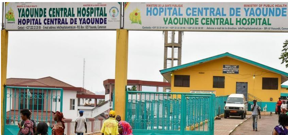
Photo 2: Entrée principale de l'hôpital central de Yaoundé
