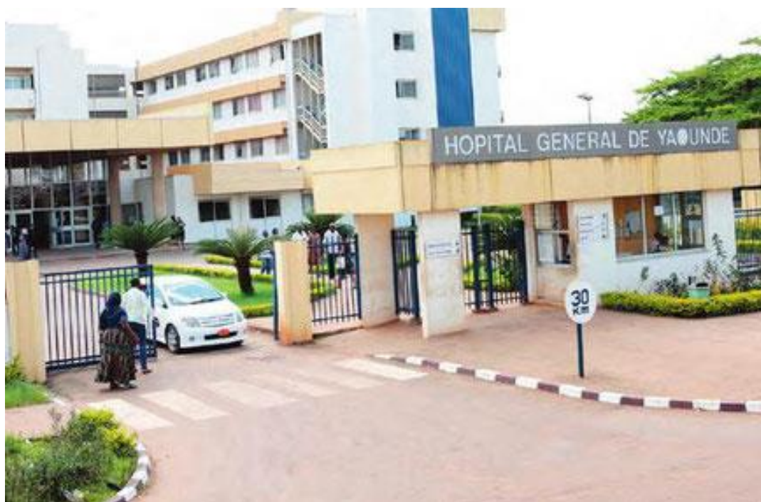
Photo 1: Entrée principale de l'hôpital général de Yaoundé
