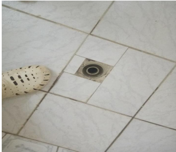
Photo 6: Trou au bloc opératoire destiné au déversement du sang à l'HD de Sarh
