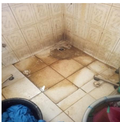
Photo 5: Fosse bouchée, trou de canalisation des eaux usées et un incinérateur non fonctionnel à l'HD de Sarh
