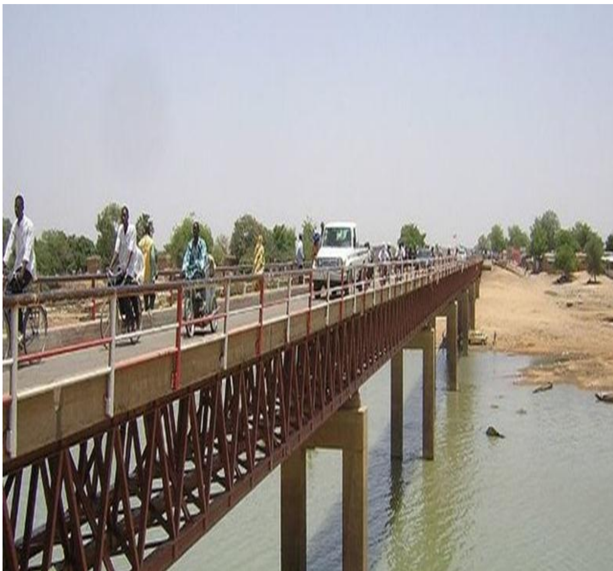
Photo n° 17: Pont sur le fleuve Logone reliant le Cameroun au Tchad.
