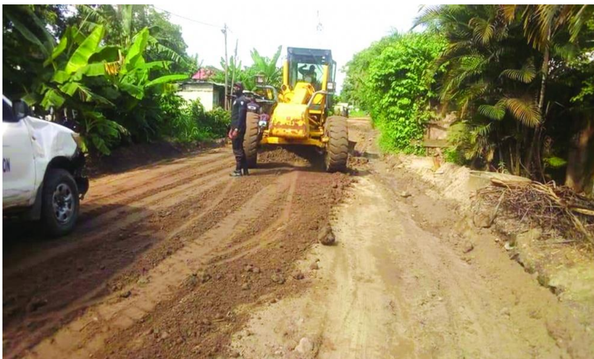
Photo N°5 : L'axe routier Otélé-Ngoumou en plein travaux d'entretien.
